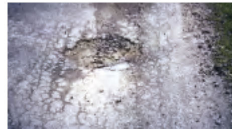
Figur 1. Islins som skapas i mark som fryser, samt ett exempel på tjälskott i väg.
